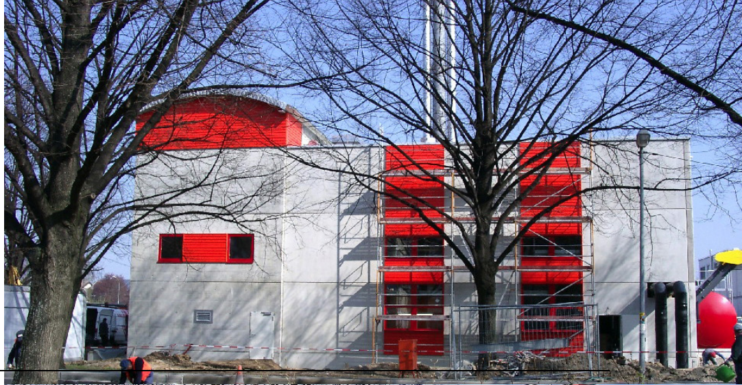
εικόνα 3.13_Το εργοστάσιο συμπαραγωγής θερμότητας και ισχύος (Combined Heat and Power-CHP) παρέχει ηλεκτρικό ρεύμα και θέρμανση στο Vauban
