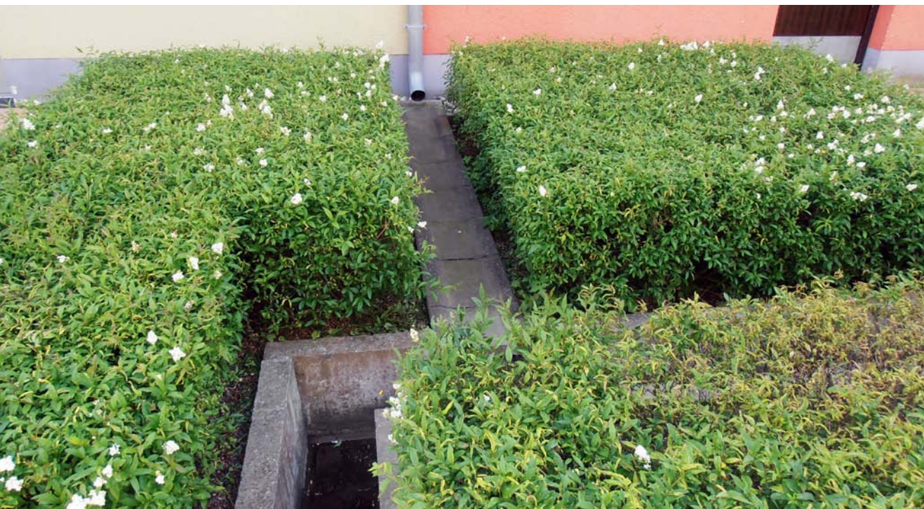
εικόνα 3.34_Ανοικτά κανάλια ομβρίων υδάτων
