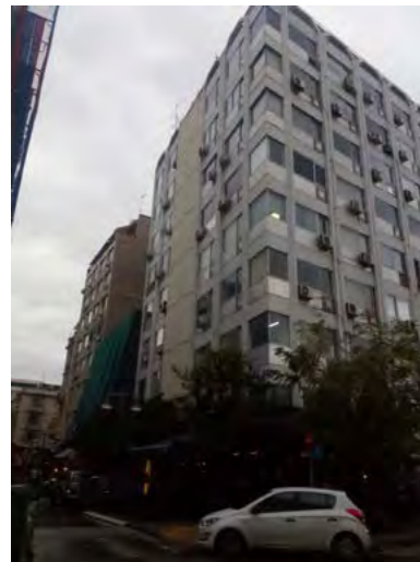
Εικόνα 28. Πολυκατοικίες που χρήζουν βιοκλιματικής αναβάθμισης
